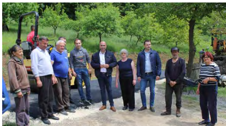
Асфалтирање у Степању
